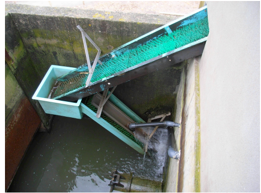
Figure 8 : Schéma Passe-piège à Anguille situé entre l'étang et le canal d'Arles à Fos (MRM)
